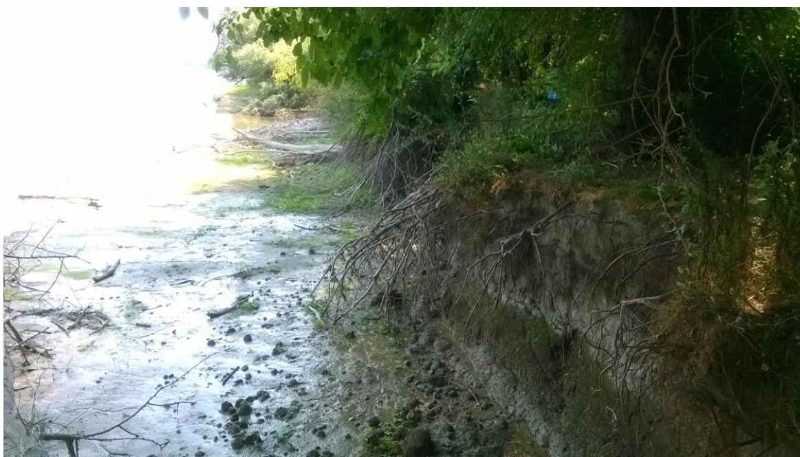
Slika 8: Erozija niske obale na području lokacije zahvata, uzvodno od lokacije prvog T-pera 21-D/1
